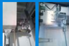
limitador bajo cabina por correa dentada
